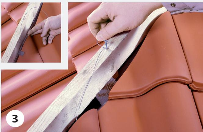
Der aufstehende Draht wird mittels Schraube oder Nagel an der darüberliegenden Lattung befestigt.
