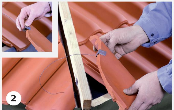
Die Kehl- und Gratklammer wird auf den jeweiligen Ausspitzer aufgesteckt und verkeilt sich so mit dem angeschnittenen Dachziegel.
