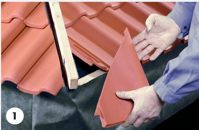
Die Ausspitzer in der Kehle oder am Grat werden passend zugeschnitten und eingedeckt. Am Grat werden die Ausspitzer mit einer schmalen Fuge an die Gratlatte angearbeitet. An der Kehle sollte die jeweilige Mindestüberdeckung nach dem Regelwerk eingehalten werden. Alle Dachziegel in der Kehle oder am Grat, die aufgrund des Anschneidens keine Aufhängenasen mehr haben, müssen gegen Abrutschen gesichert werden.
