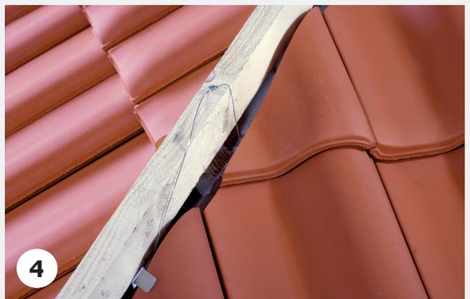
Die Kehl- und Gratklammer deckt einen Klemmbereich von 7 bis 22 mm ab und ist damit für alle CREATON Dachziegel-/Dachsteinmodelle geeignet.
